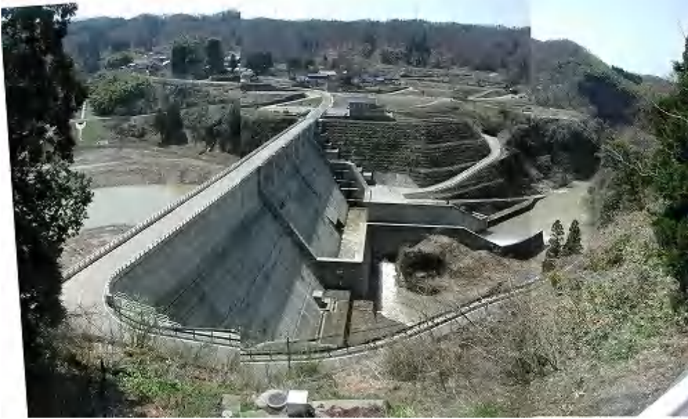
【写真2】 ダム全景（右岸の県道からダム全景を望む、右が下流）
