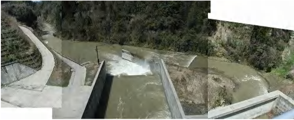
【写真4】ダム堤体上から下流を望む
