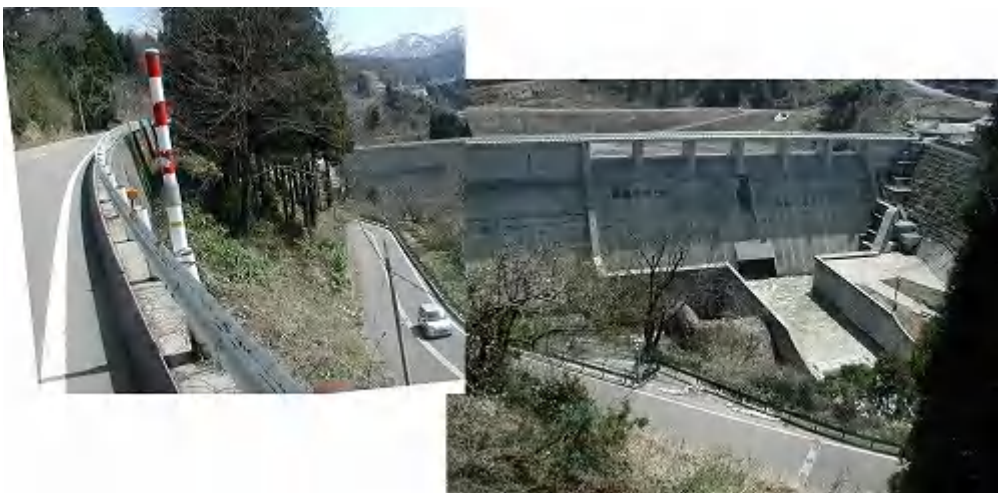
【写真 1】辰巳ダム堤体全景（右岸の県道から、ダム前面を望む）
